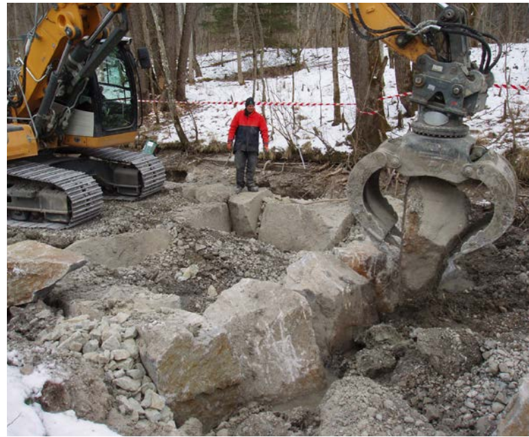
Bild 29: Errichtung eines Raugerinnes in Beckenstruktur
