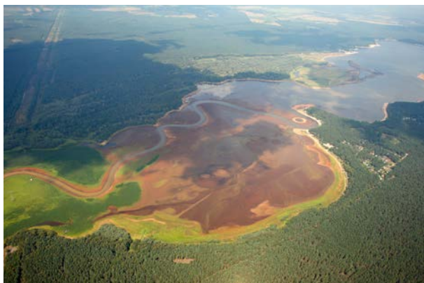
Bild 46: Die Talsperre Spremberg 2014 vor Beginn der Konditionierungsmaßnahme
