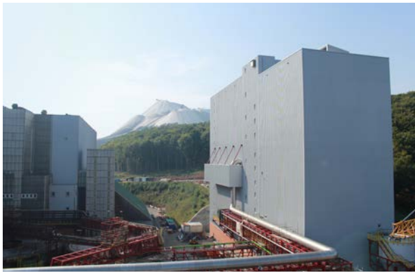
Bild 48: Ansicht auf die Kainit-Kristallisations-Flotationsanlage (KKF-Anlage)
