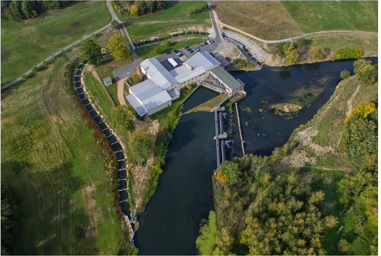
Bild 26: Luftaufnahme der Fischaufstiegsanlage
