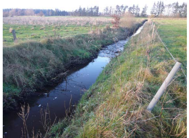
Bild 20: Ansicht der Linnau vor der Maßnahme
