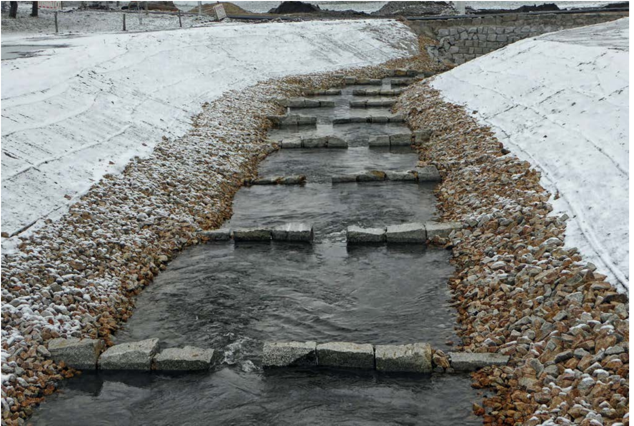
Bild 27: Ein Teil der Fischaufstiegsanlage im Detail
