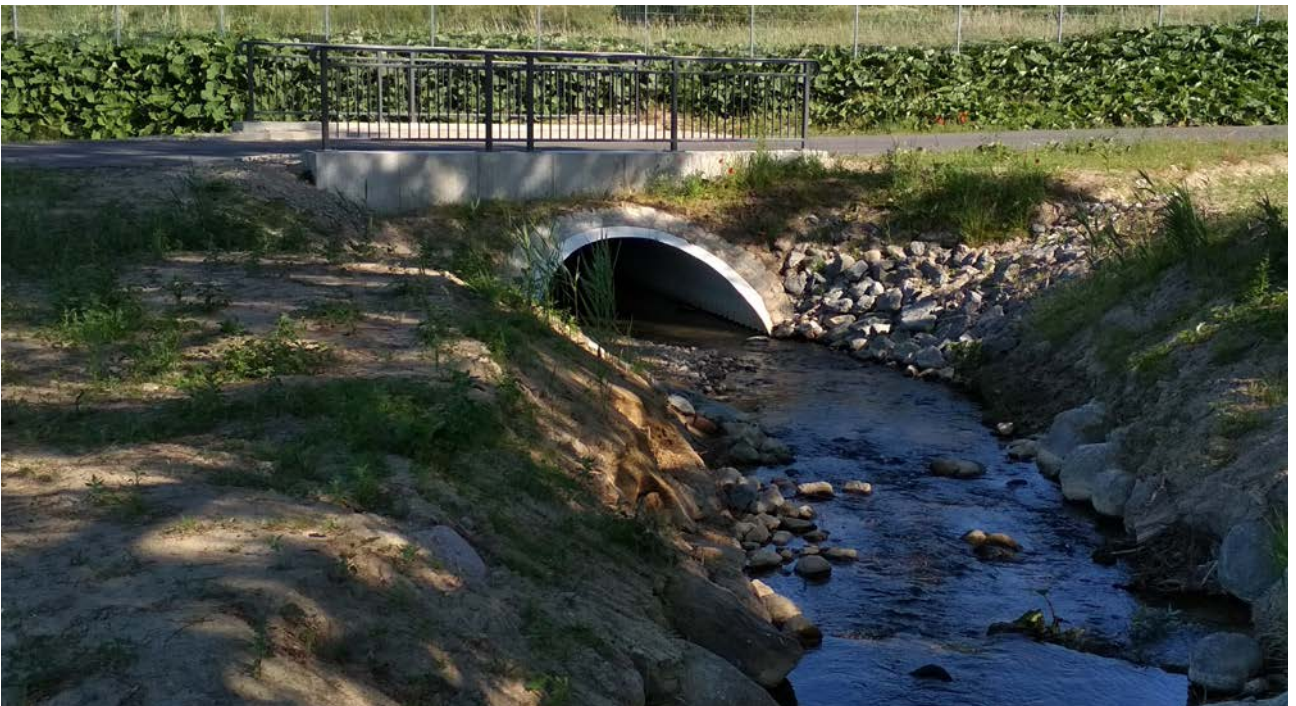
Bild 5: Durchgängiger Durchlass im Sagarder Bach, Mecklenburg-Vorpommern
