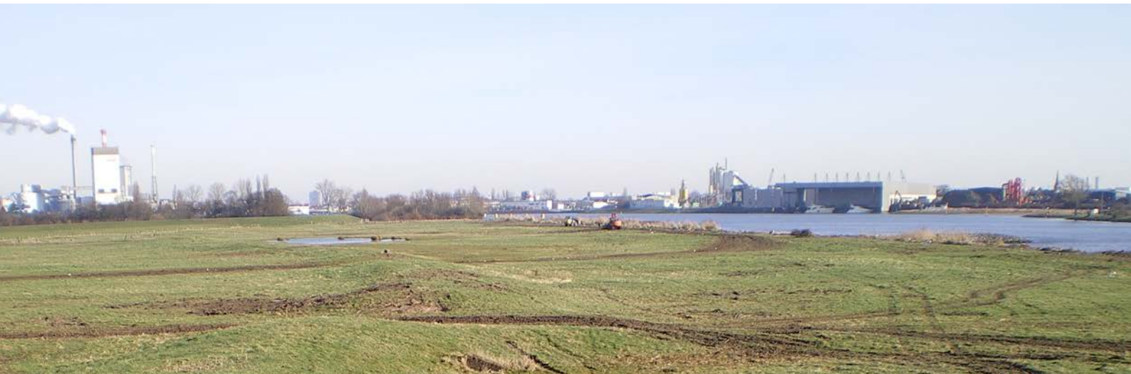
Bild 8: Die Weser bei Habenhausen war vor der Maßnahme strukturarm
