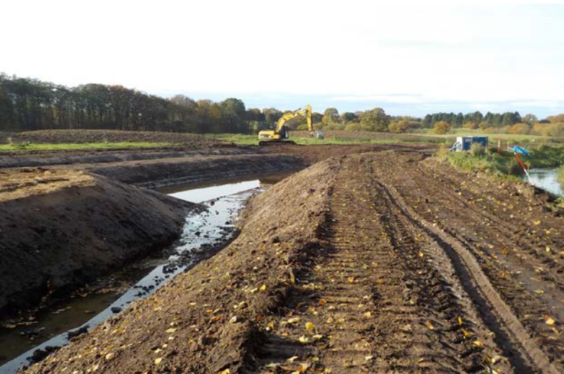
Bild 12: Baggerarbeiten während der Baumaßnahme
