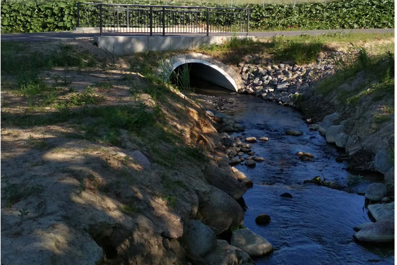
Bild 25: Ansicht nach Rückbau des Querbauwerkes
