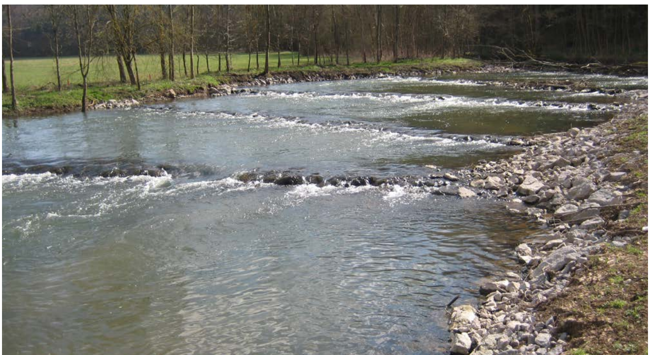
Bild 32: Blick auf die Werra nach Rückbau des Wehres
