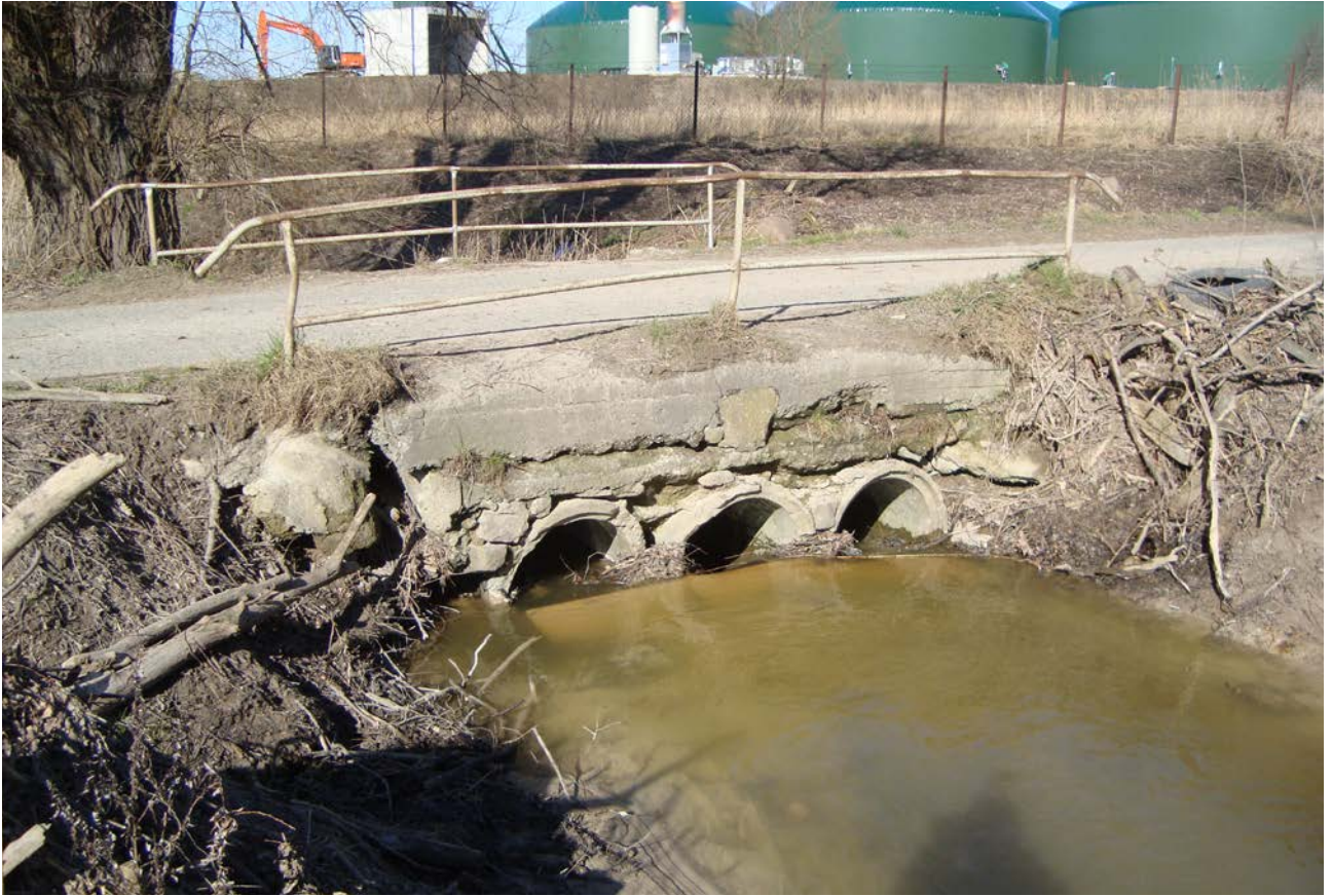
Bild 24: Der Sagarder Bach vor Rückbau eines der beiden Querbauwerke
